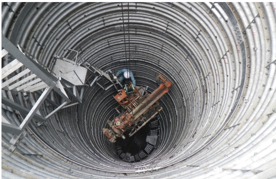
Figura 2.7 – Ilustração de um poço vertical de acesso revestido com painéis metálicos
