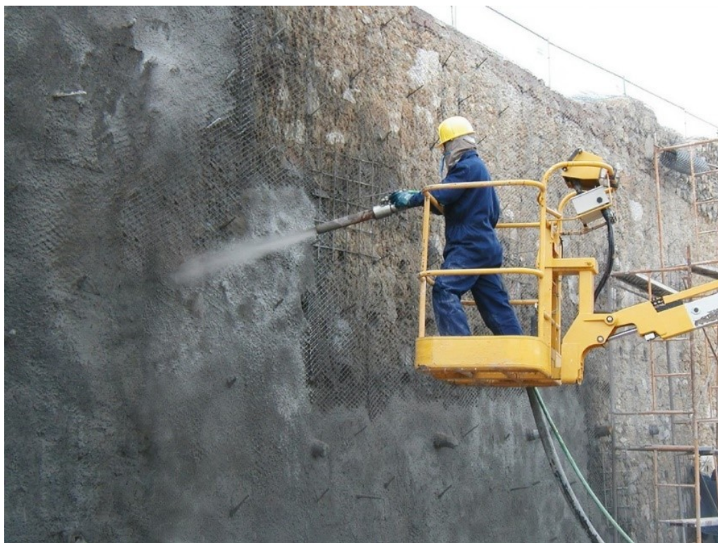
Figura 2.17 Ilustra a projecção de concreto na construção de um túnel subterrâneo
