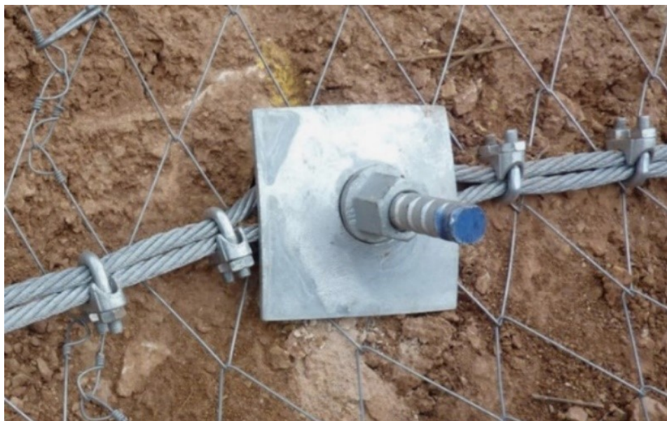
Figura 2.14 – Aplicação de parafusos de ancoragem, cabos e malhas de aço em zona com elevado índice de queda de blocos.
